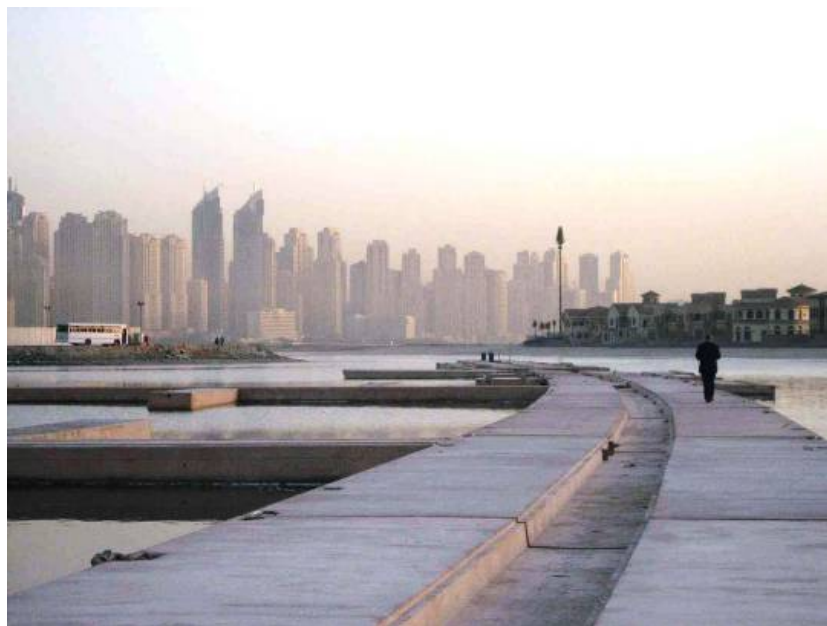
Figura 7: Anchor Marina en Construcción, Palm Jumeirah, Dubai, EAU
